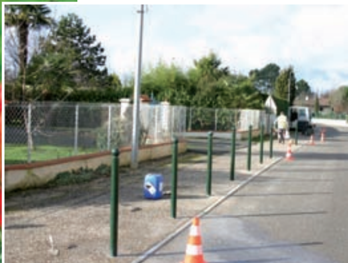
Travaux de sécurisation du Chemin de Rappetout par l'installation de poteaux permettant aux enfants et aux familles d'utiliser les trottoirs en toute sécurité
