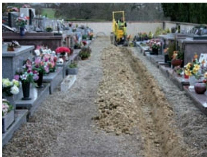
Réfection du réseau d'alimentation d'eau suite à une fuite d'eau
