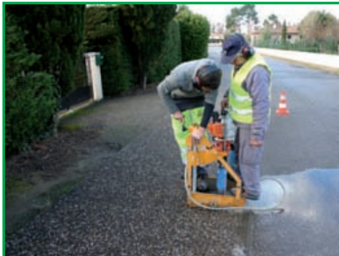
Travaux de sécurisation du Chemin de Rappetout par l'installation de poteaux permettant aux enfants et aux familles d'utiliser les trottoirs en toute sécurité
