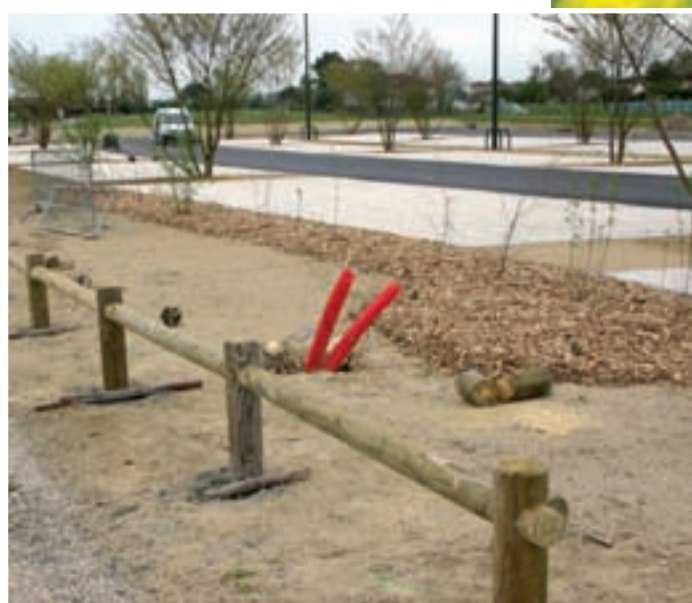
Travaux parking de la halle
