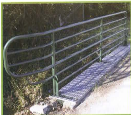
Travaux de remise en état de la rampe de sécurité du Pont de Gravère
