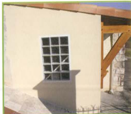
Toilettes publiques en cours de finition au nouveau cimetière
