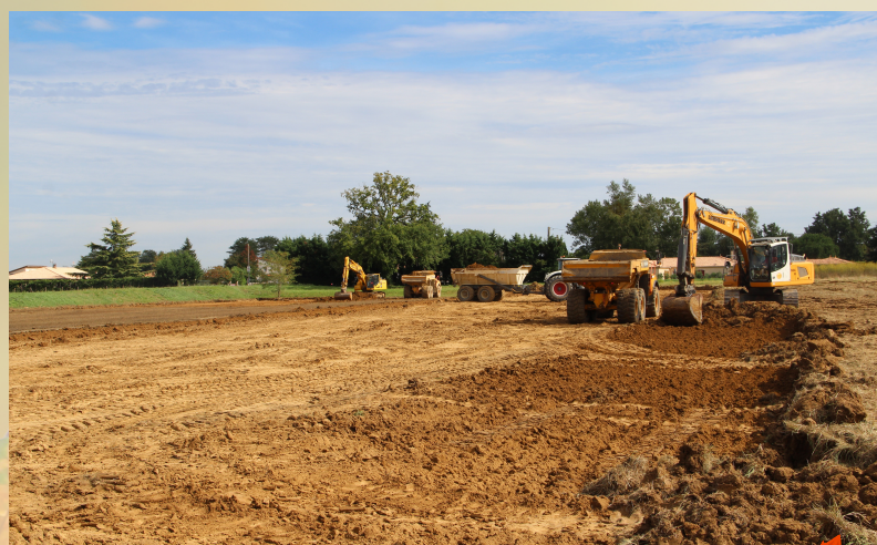
Réalisation du bassin d'écrêtement de 18 000m 3 au lieu-dit "Balangelis"
