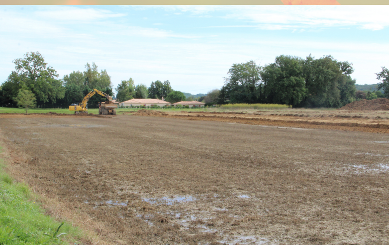
Réalisation du bassin d'écrêtement de 18 000m 3 au lieu-dit "Balangelis"
