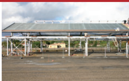
Novembre 2013, la couverture de la toiture et l'isolation phonique...
