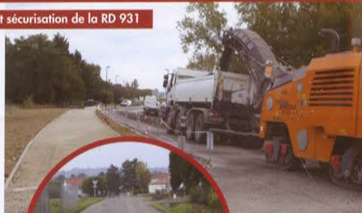
Travaux d'enduits d'usures sur des voies communales
