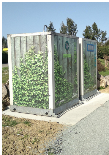
Chemin Puits de Carrère
